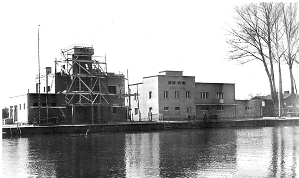
Zdjęcie nr 43. Przystań wioślarska PKS-u Kalisz (w budowie) w 1935 roku
