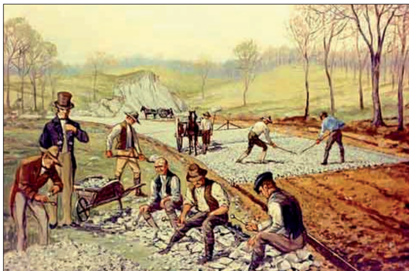
Rys. 2 Budowa drogi z zastosowaniem technologii McAdama (makadamu) w 1823 roku.
