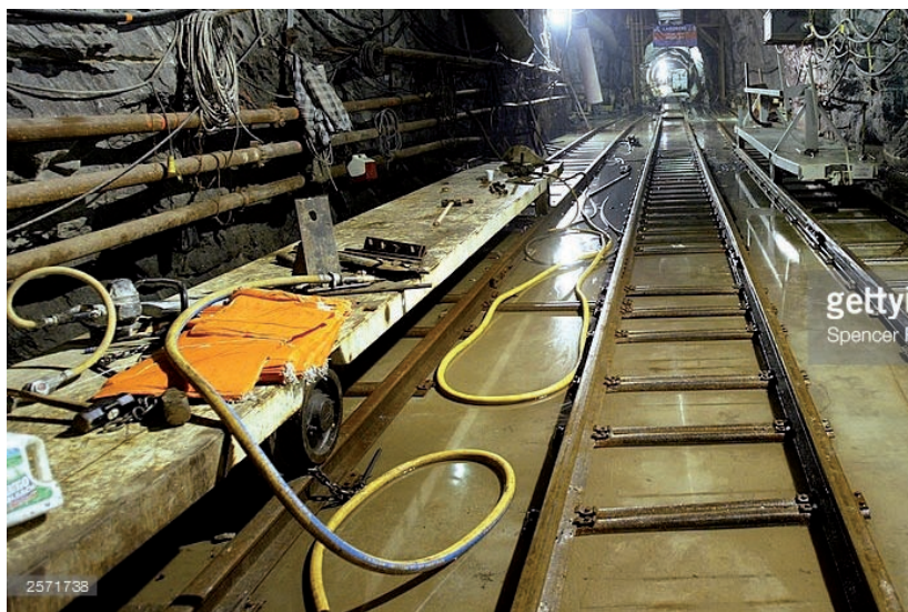
Rys. 6 Budowa miejskiego tunelu wodociagowego nr 3.
