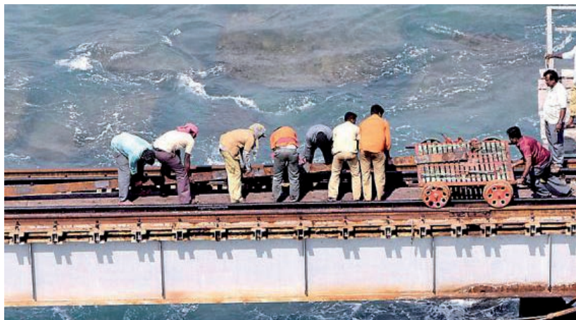
Rys. 3 Prowadzenie prac o charakterze antykorozyjnym
