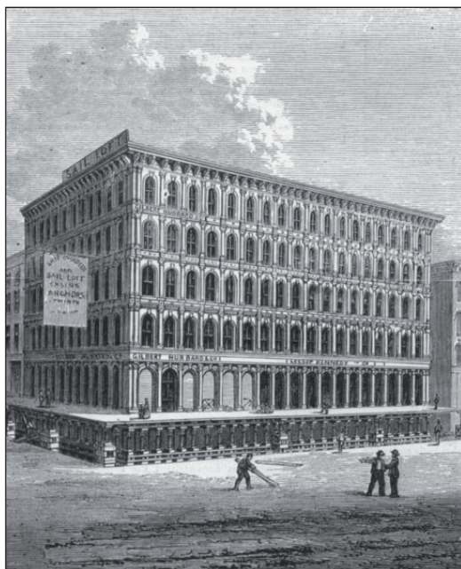
Rys. 4 Budynek w Chicago umieszczony na podnośnikach śrubowych
