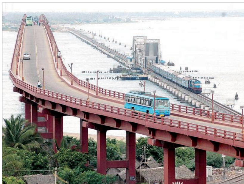
Rys. 4 Widok na most kolejowy i most drogowy
